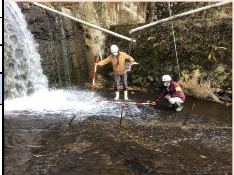
砂防施設点検調査
