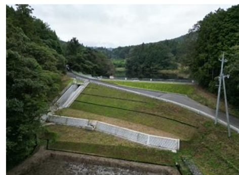
改修したため池
