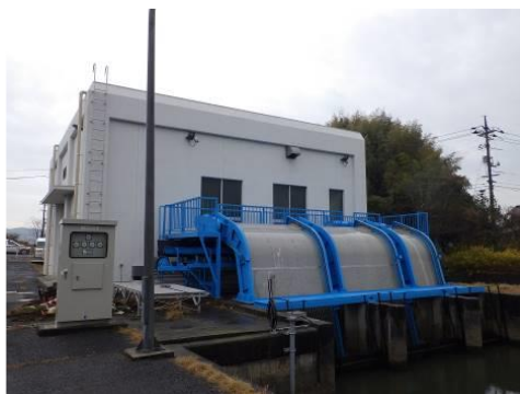
農業用排水機場の機能保全対策
