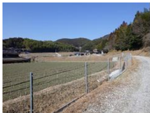
獣害防止柵の設置
