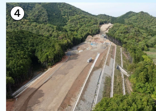
1 号トンネル付近
