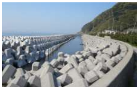
海岸保全施設
