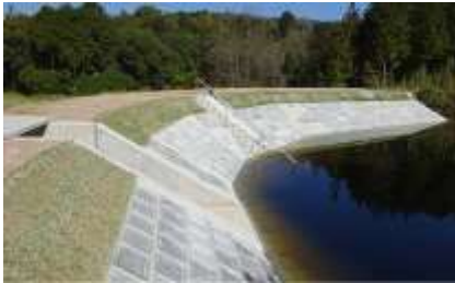
危険ため池の整備
