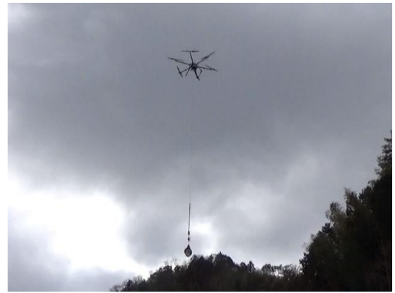
図5 ドローンによる器材運搬
