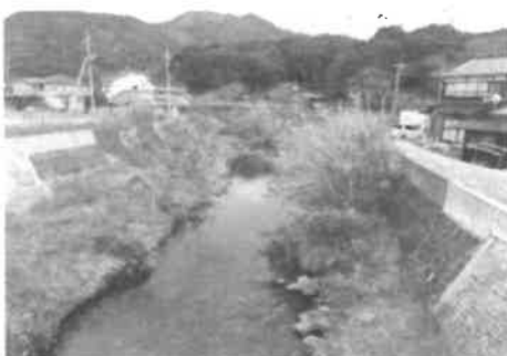
【改修前、現在の須佐川】
