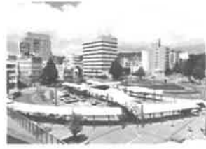
徳山駅北口駅前建設工事
