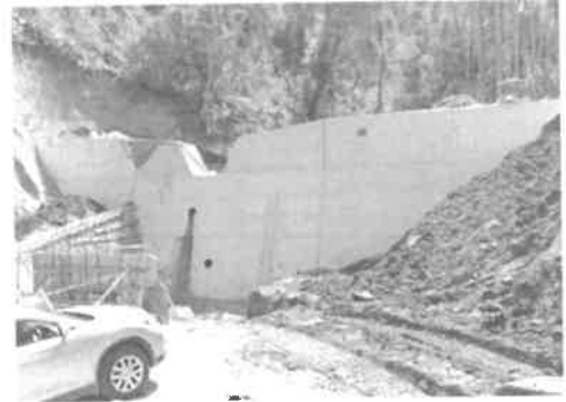
谷止工施工状況（竹田地区）
