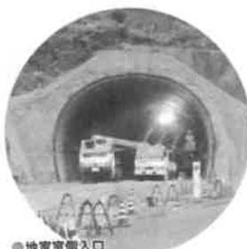
●地家室側入口
