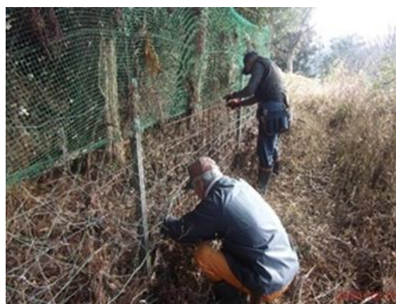
防護柵の設置作業 (美祢市 砂地集落協定)
