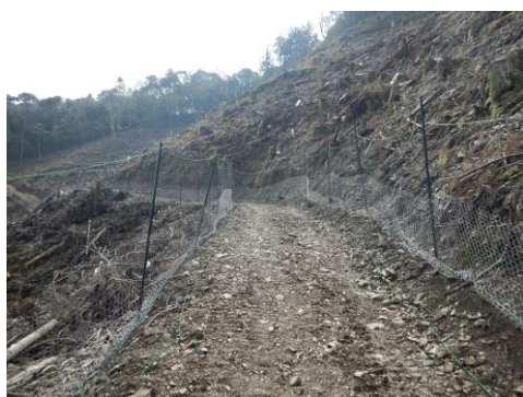
[鳥獣害防止施設等整備] シカ防護柵設置事業地 (長門市)
