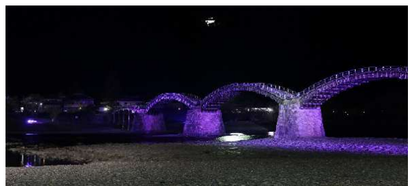
岩国市「錦帯橋」
