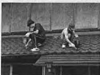
空き家改修の支援
