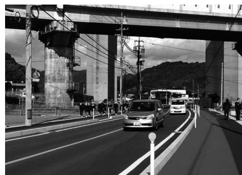
通学路の歩道整備
