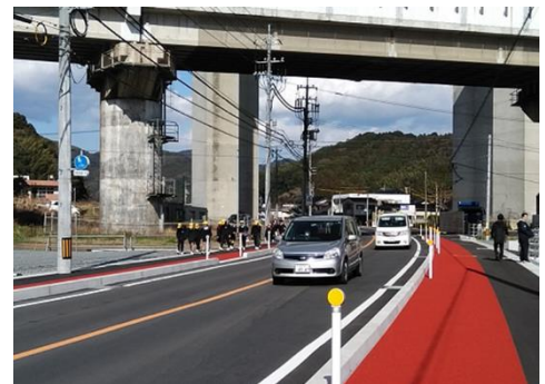
通学路の歩道整備
