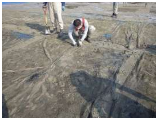
破損した被覆網の修繕
