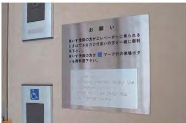
全盲の視覚障害者のため点字パネルを設置
