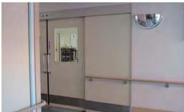
廊下の曲がり角の向こうが見えるようにカーブミラーを設置
