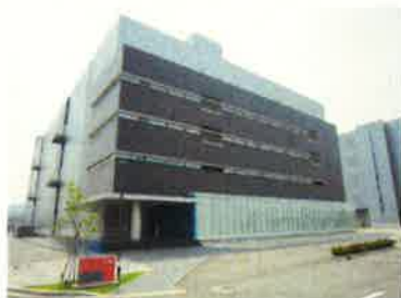
固形製剤製造棟
