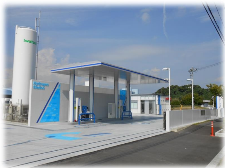
イワタニ水素ステーション山口周南
