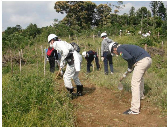
歩道の整備作業
