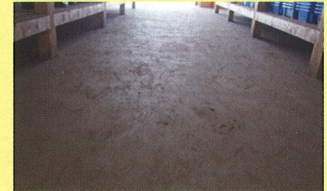
出荷調整棟 (改善前)
