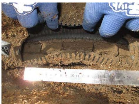
第12図 パイプ内の土砂の堆積状況(洗浄前)
