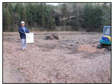
再生作業実施中
