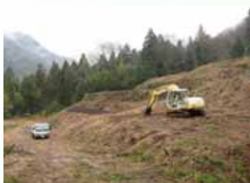
再生作業実施中
