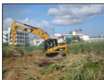
再生作業実施中
