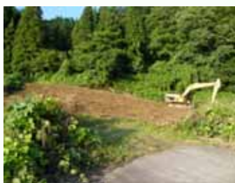
再生作業実施中
