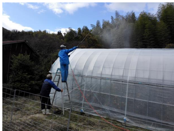
図2 遮光塗布剤をハウスのビニルに散布
