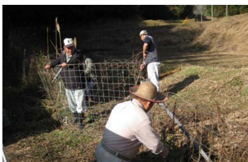
防護柵の設置
