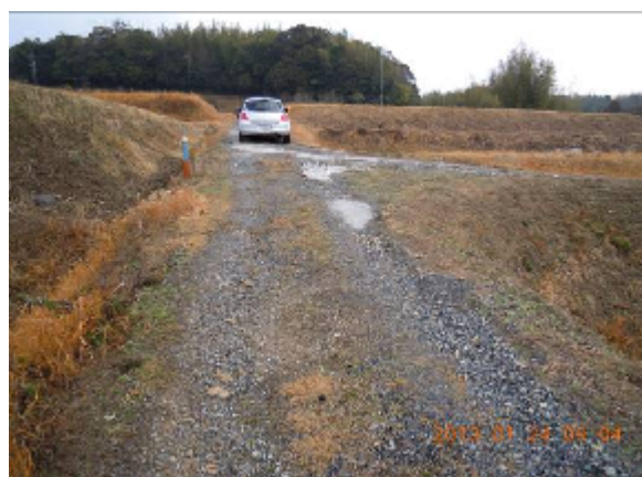
【 舗装工事予定の農道】
