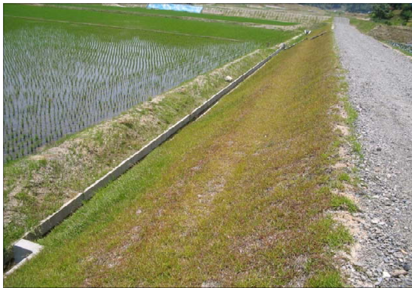
新規法面における施工事例
