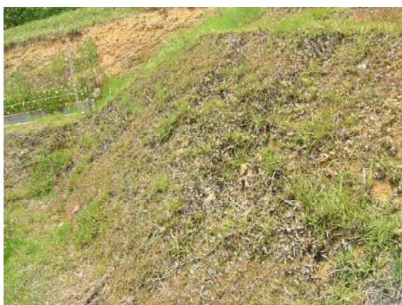
野焼きを行った法面
