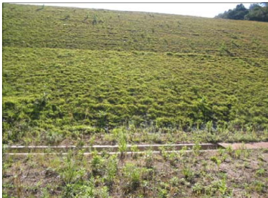
ため池法面における施工事例
