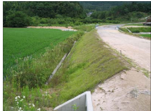
農道法面における施工事例
