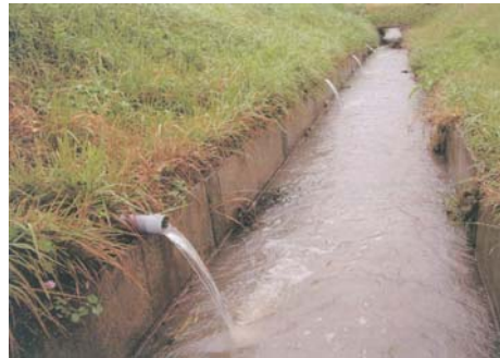
降雨後の排水状況
