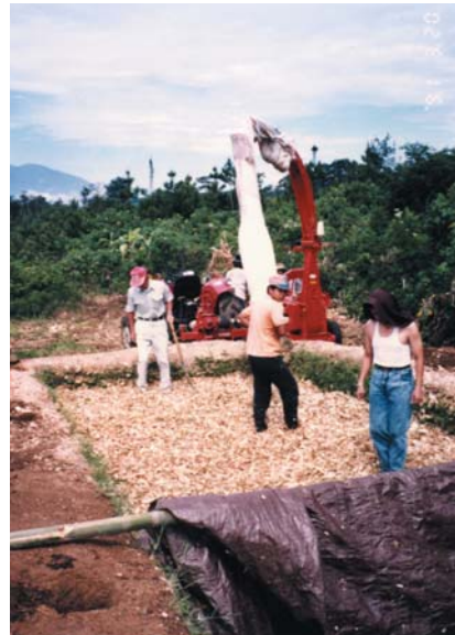
素掘トレンチサイロ詰込（踏圧作業内面にプラスチックシートを張る）
