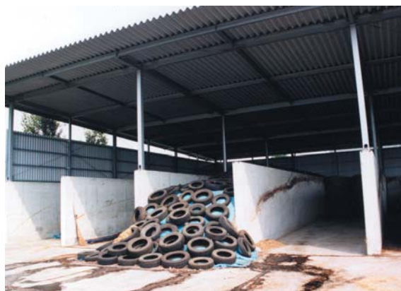
屋根つきバンカーサイロの密封・貯蔵状態（重石は古タイヤ）
