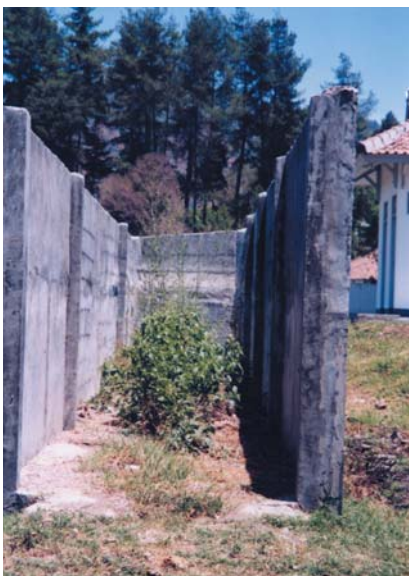
コンクリート製バンカーサイロ（二次発酵防止のため間口は狭い）
