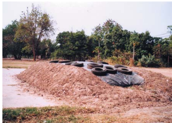
床面をコンクリート、側面を盛土したサイロ
