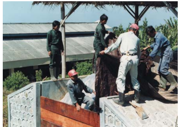
プラスチックシート被覆作業（椰子の葉を利用して屋根を設置し、直射日光を遮断）
