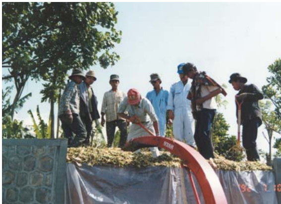
コンクリートのトレンチサイロ（詰込、均平、踏圧）
