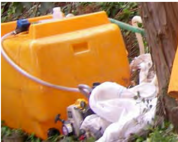
タンク及びポンプの設置
