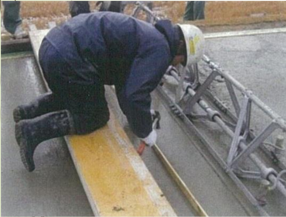
打込目地設置状況
