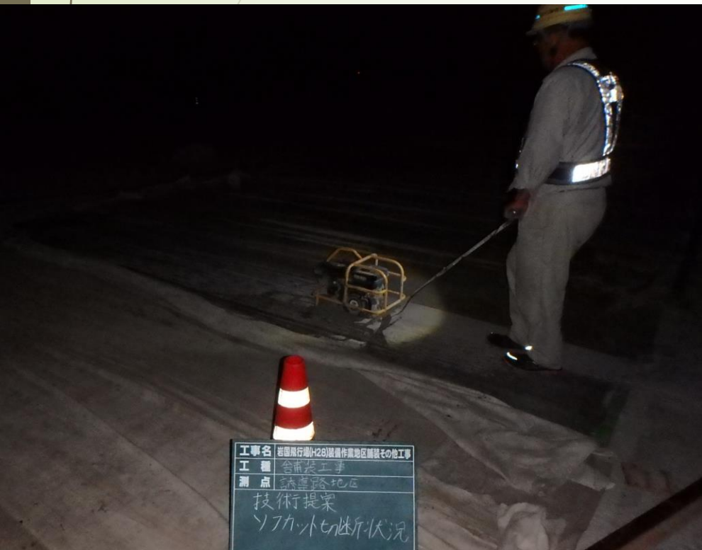
ソフカットを使用した目地切断
