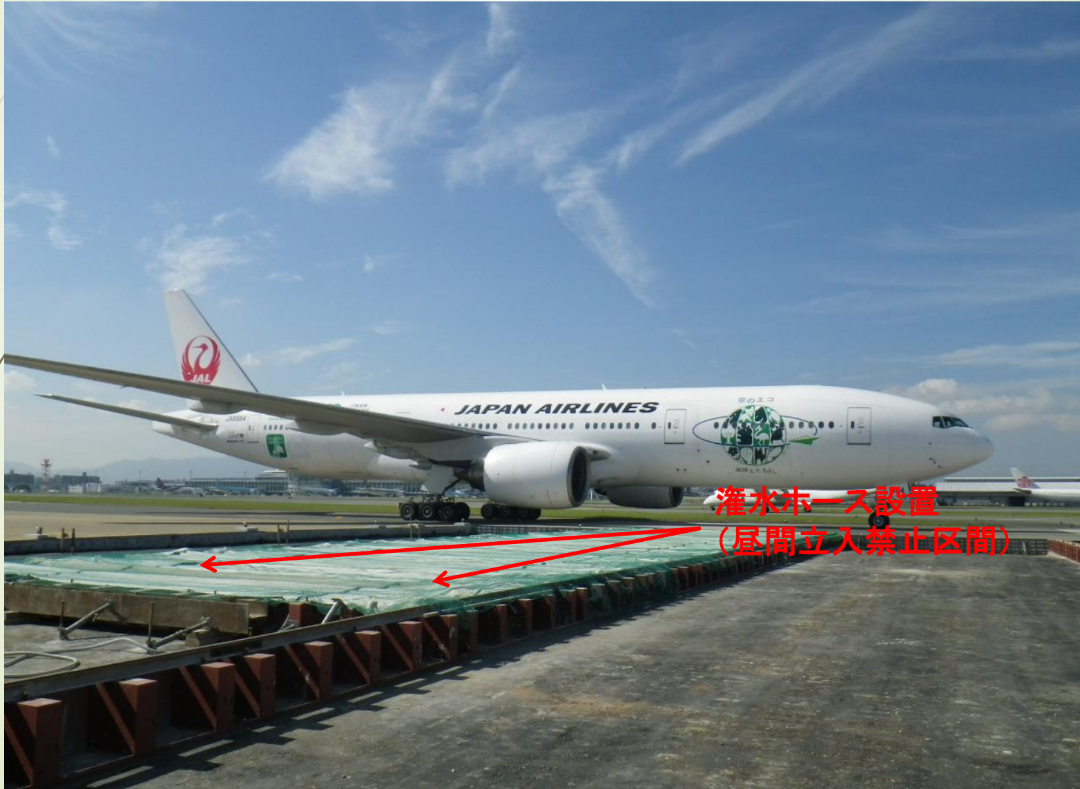
飛散防止ネットの設置
