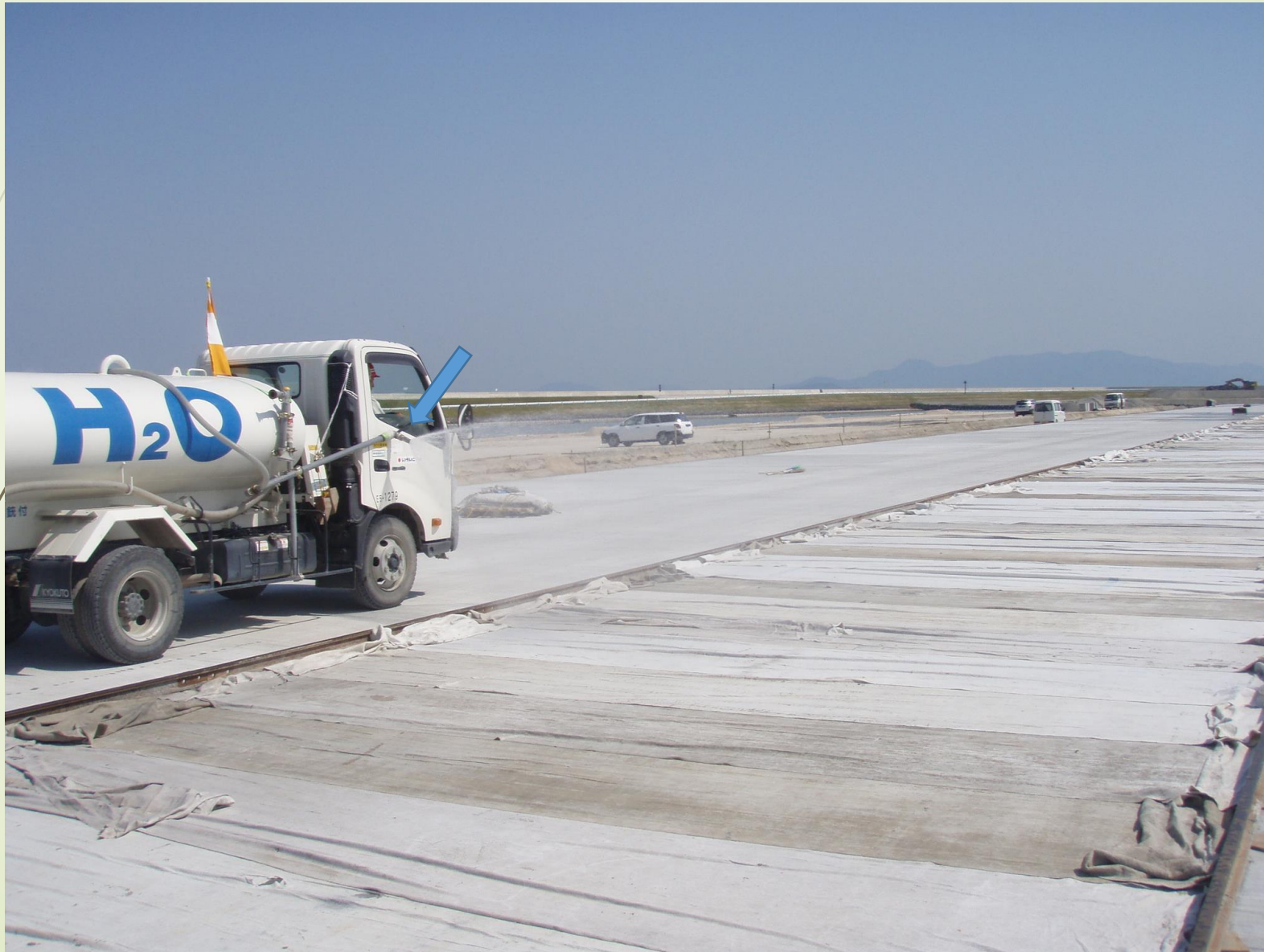
養生マット敷設後の追加散水
