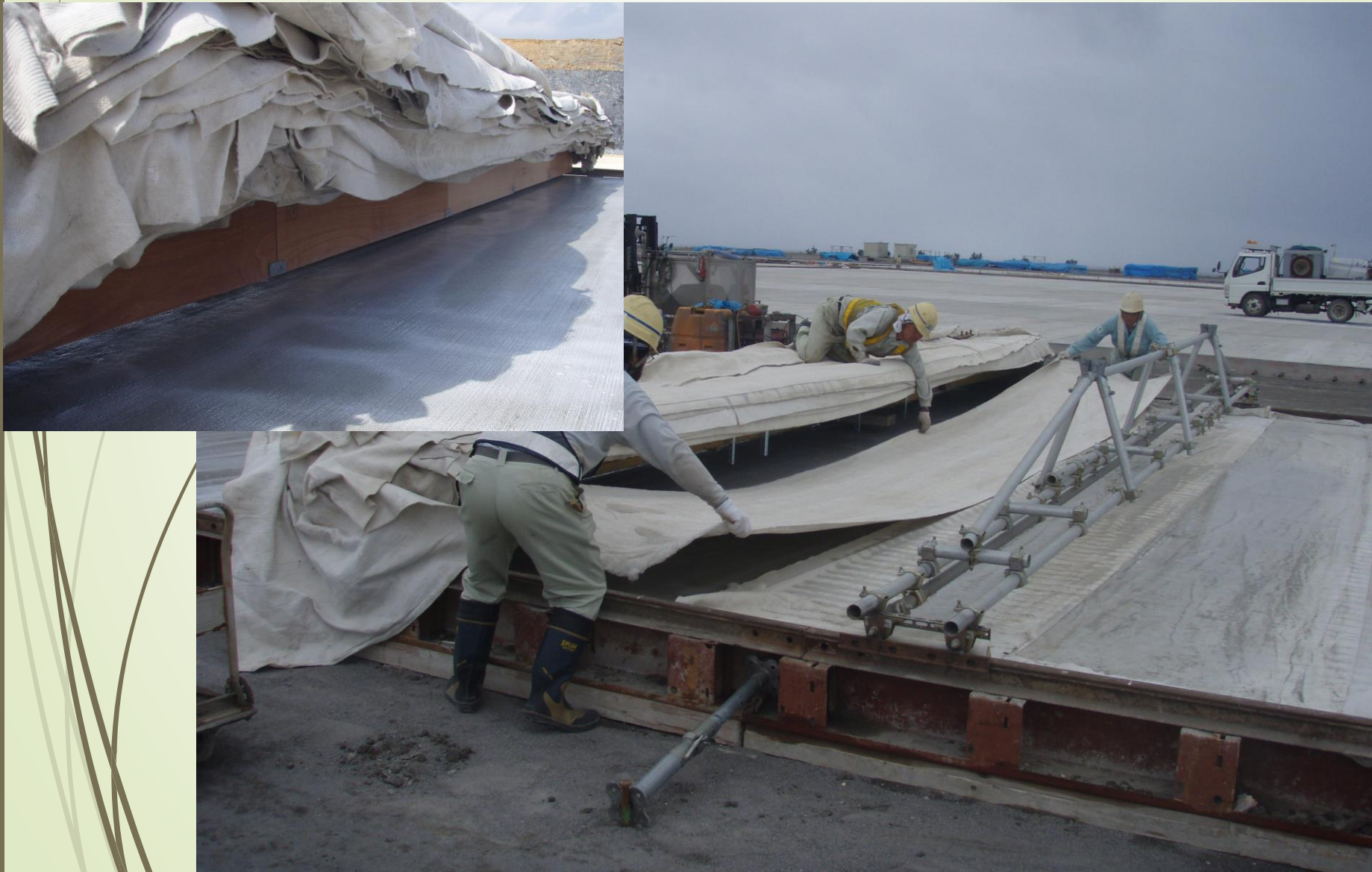
養生マット敷設・散水養生
