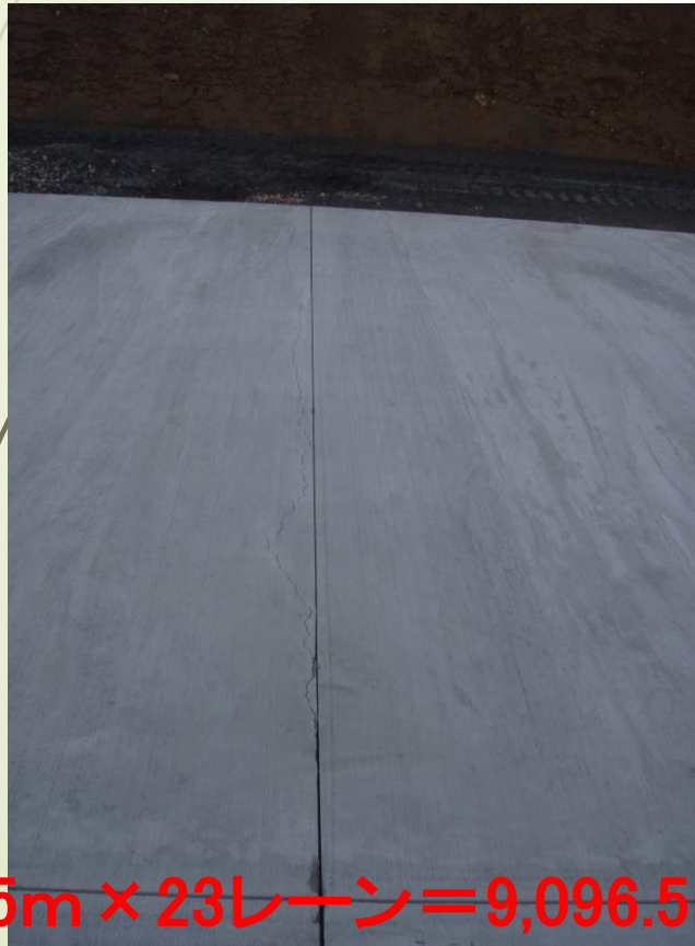
温度ひび割れの例
