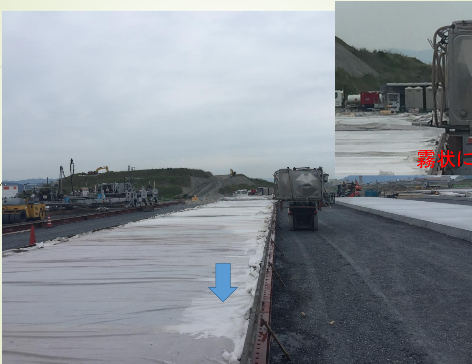
養生マット敷設・散水養生
