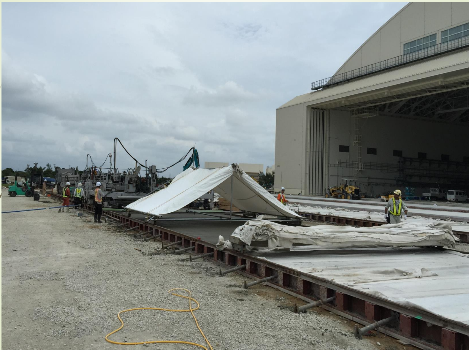
養生マット敷設前の日除け
