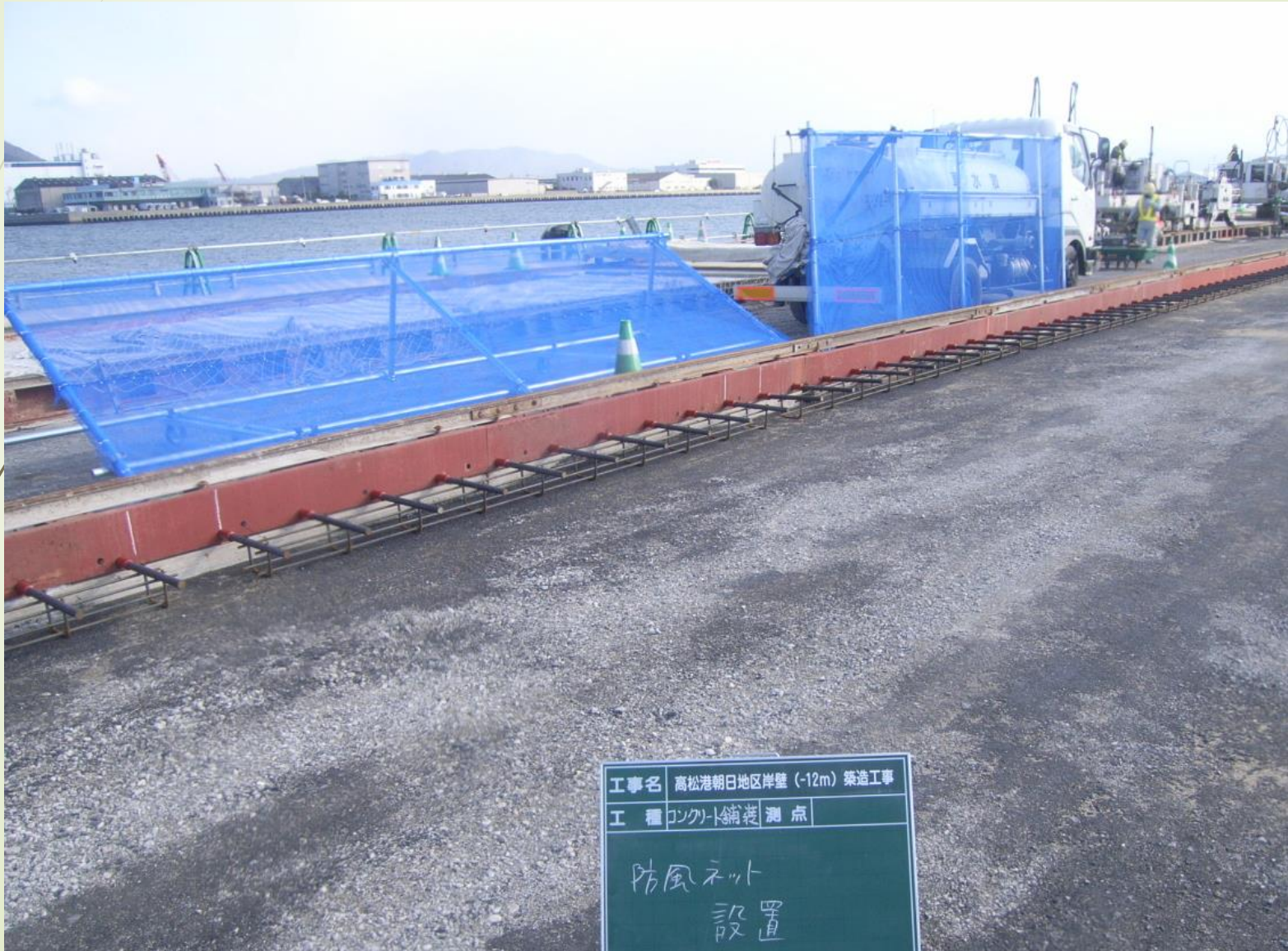
養生マット敷設時の風除け
