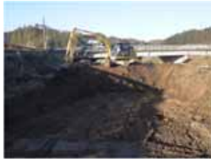
(使用機械、掘削方法)
