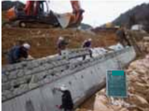
(使用機械、据付方法)
