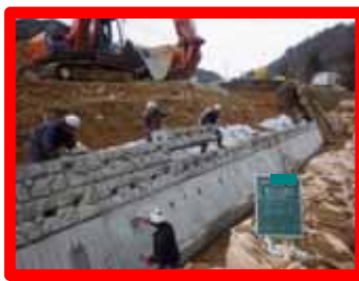
(使用機械、据付方法)
