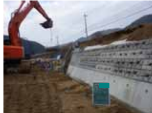
(使用機械、据付方法)
