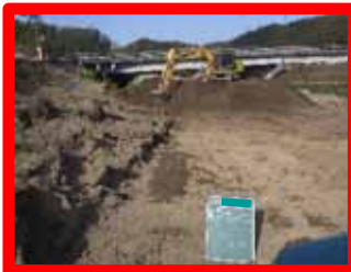
(使用機械、掘削方法)
