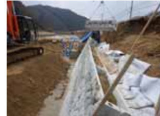
(使用機械、据付方法)
