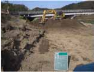
(使用機械、掘削方法)
