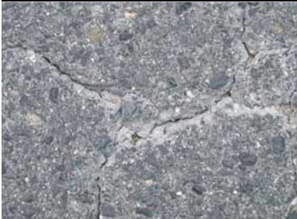
沈下・ひび割れ(路体沈下による)
