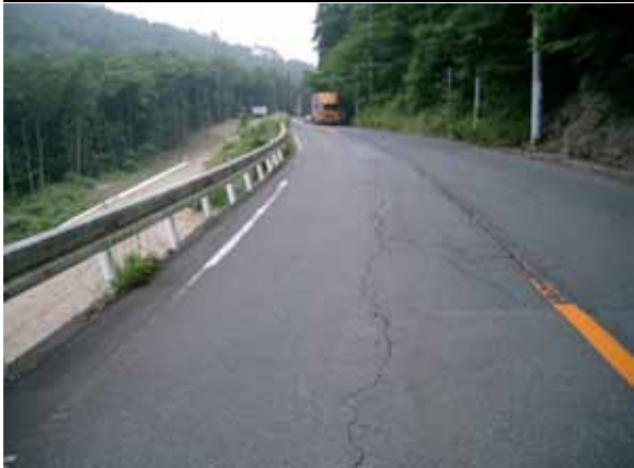
沈下・ひび割れ(路体沈下による)
