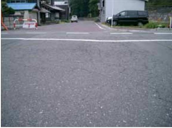
線状クラック（施工ジョイントによる）
