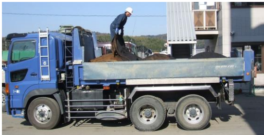
写真は合材運搬時の養生シート設置状況（温度低下による品質低下を防ぐ）
