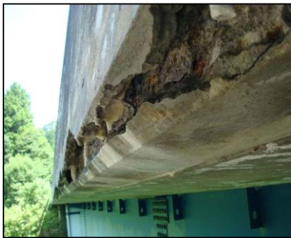
コンクリートの損傷 (鉄筋のさび)
