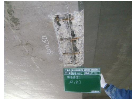
橋梁点検による損傷 確認箇所
