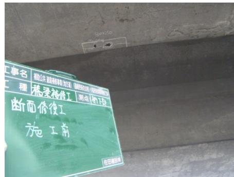
橋梁点検による損傷 確認箇所
