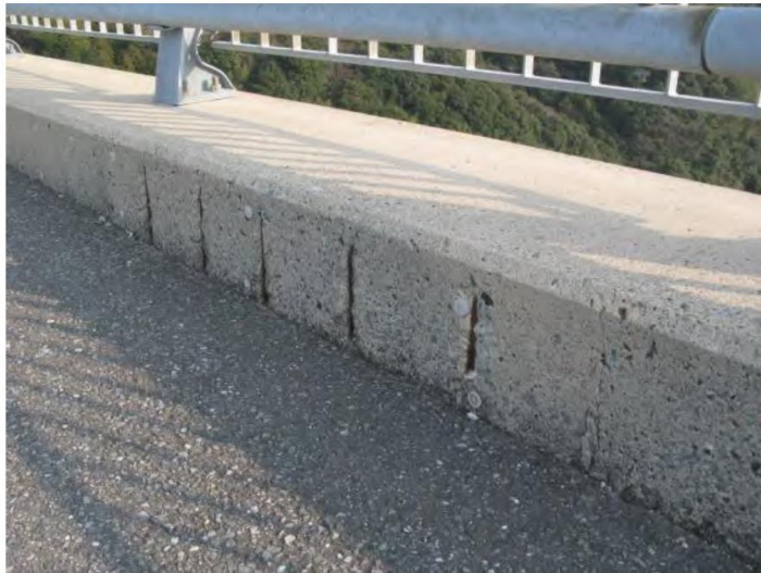
【かぶり不足のコンクリート構造物で発生した鋼材腐食の例】
