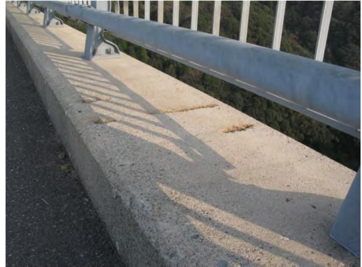
【かぶり不足のコンクリート構造物で発生した鋼材腐食の例】
