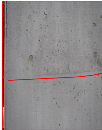
【悪い打重ね】 打ち重ねの上下で施工による不具合がある
