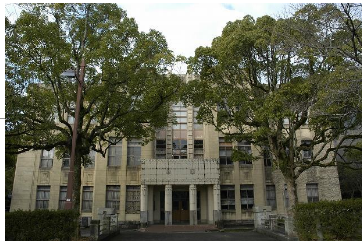
技術センターが入所している春日山庁舎 (旧県立図書館:昭和3年築)
