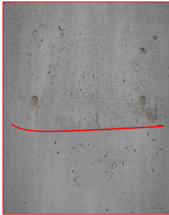
【悪い打重ね】 打ち重ねの上下で施工による不具合がある
