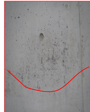
【悪い打重ね】 打ち重ねの上下で施工による不具合がある
