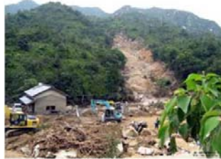
土砂災害発生現場
