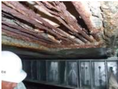
凍結抑制剤による塩害
