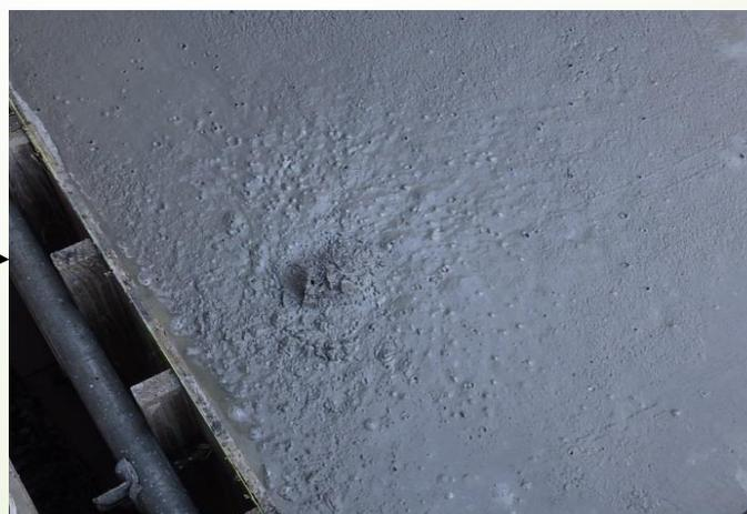
再振動の行う時期はコンクリートの状態で判断する。この現場では、コンクリート充填後、①から⑤の手順で確認し、再振動をかけた。バイブレーターは挿入深さは、40～50cm以下で挿入し、特に鉄筋に振動が伝わると、鉄筋の周囲に隙間が出来るので注意する。
