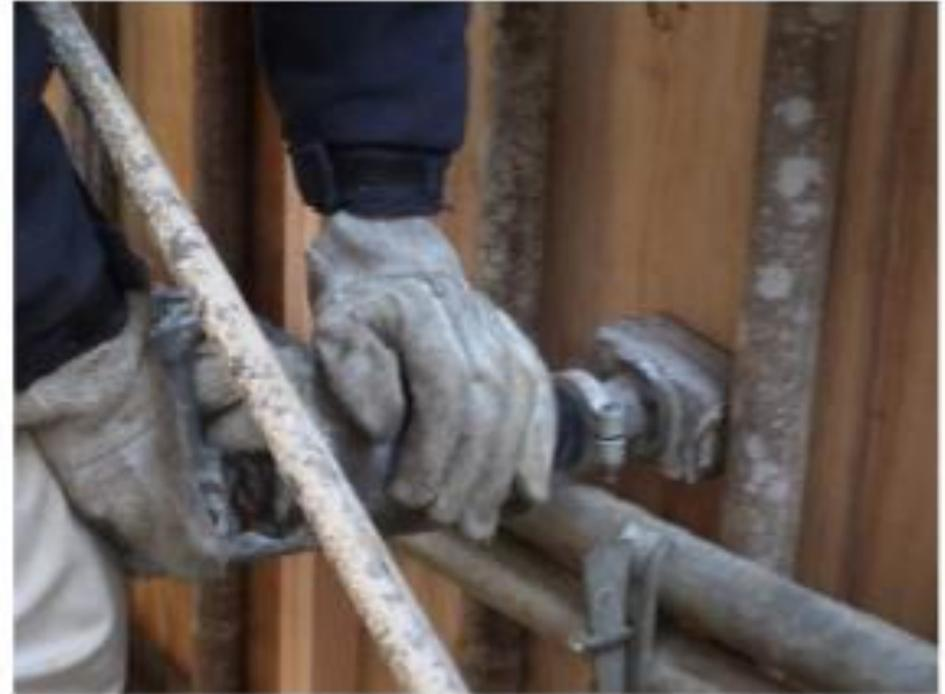
コンクリートの打込み時、ブリーディングによる水の上昇により、コンクリートが沈下するため、沈みひび割れが発生しやすい。セパレーターコン下部から、ブリーディング水・余分な気泡を抜くために、打込み高に応じて、壁面バイブレーターをかけました。
