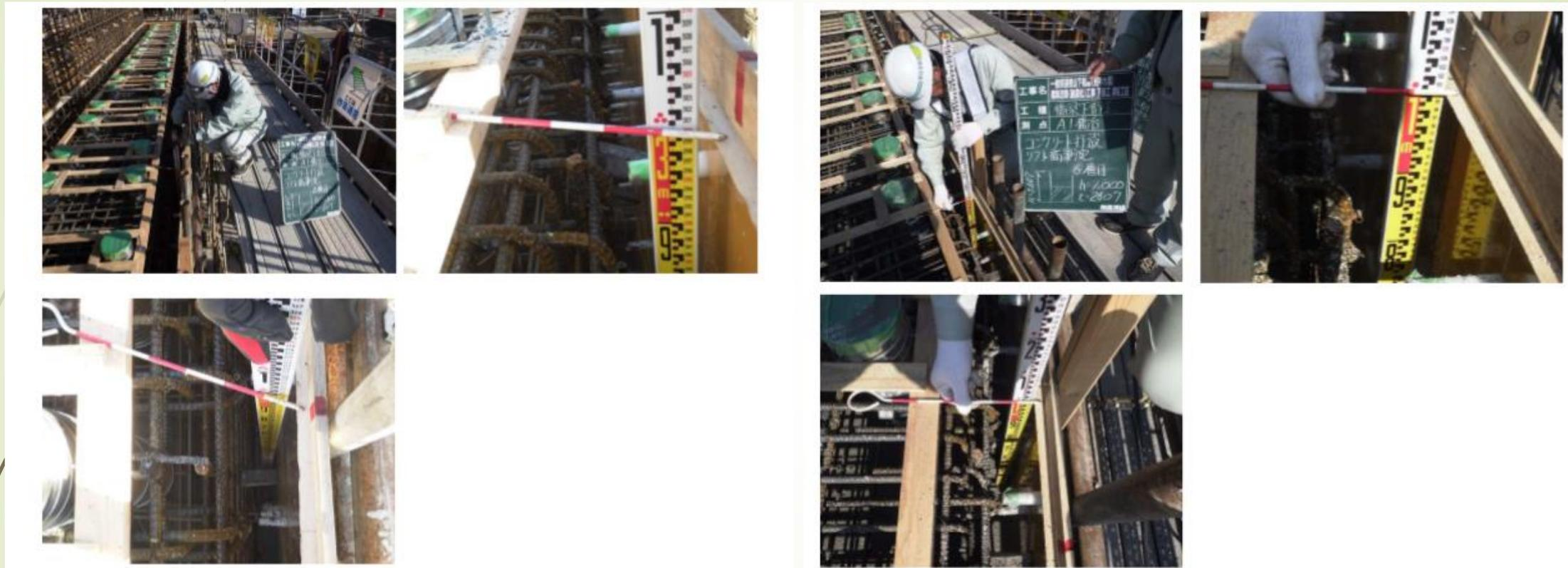
型枠天端より下がりで1層毎測定。
