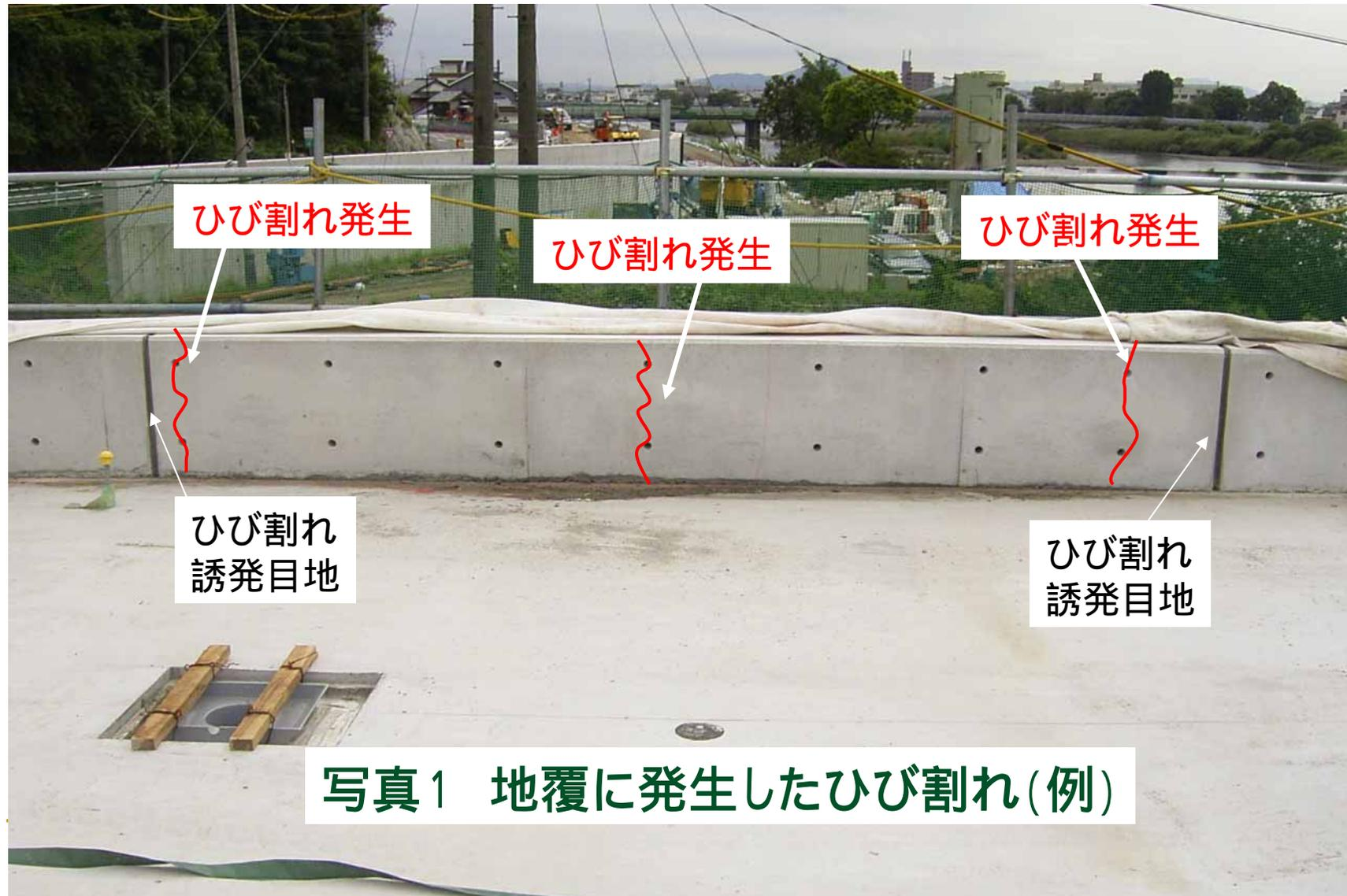
写真1 地覆に発生したひび割れ(例)
