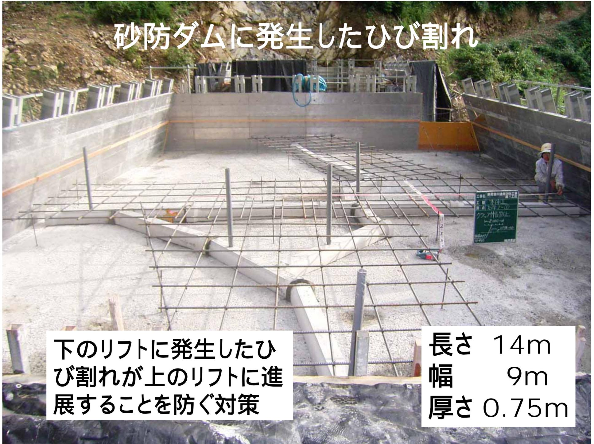
下のリフトに発生したひび割れが上のリフトに進展することを防ぐ対策
