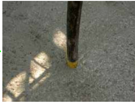
バイブレーター挿入状況
