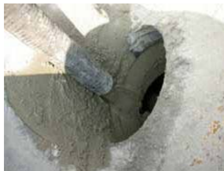
先送りモルタル状況②
