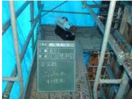
シート内部(ジェットヒータ使用)
