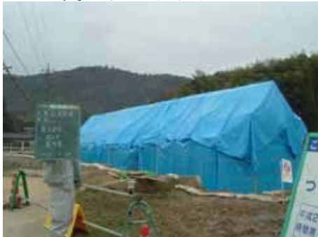
シート養生状況(1月)
