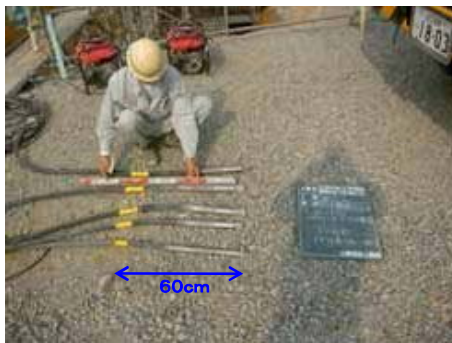
バイブレータテープ位置確認
