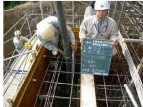
打ち込み高さ確認
