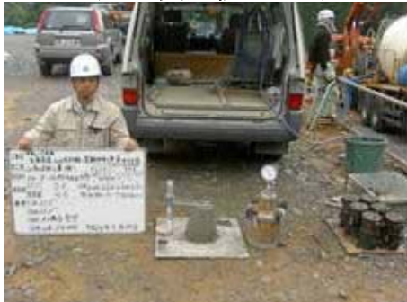
コンクリート受入検査立会
