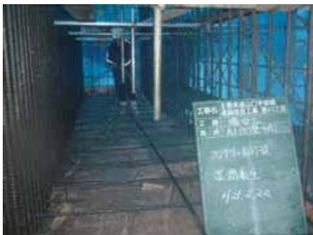
湿潤養生状況
