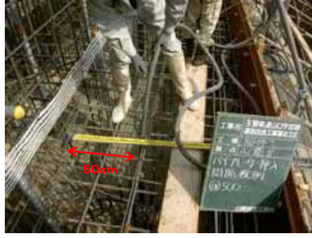
バイブレーター挿入間隔確認状況
