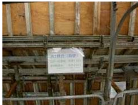
脱枠時期明記状況②
