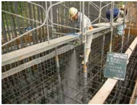
打設前散水状況
