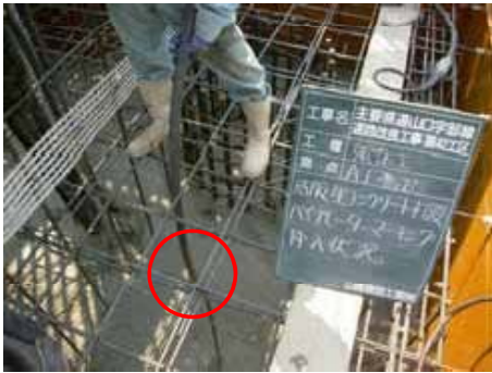
バイブレーター挿入状況
