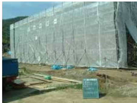
シート養生状況(6月)
