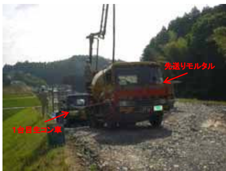
先送りモルタル状況①
