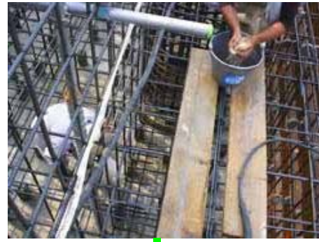
溜まり水除去状況
