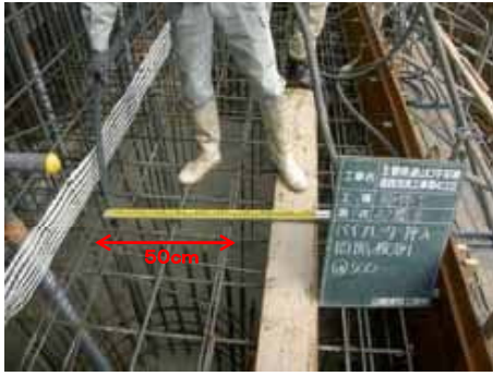
バイブレーター挿入間隔確認状況
