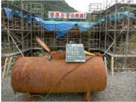
養生水(鋼製水タンク汲置)
