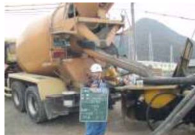
生コン温度および外気温測定（5台毎）
