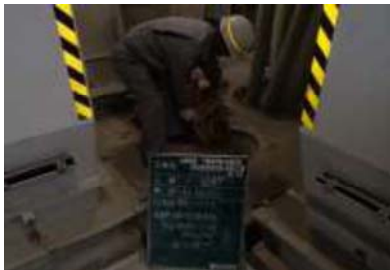
膨張材投入状況（プラント）
