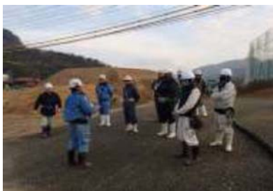
打ち込み前ミーティングの実施状況
