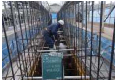
型枠面、打継面の散水
