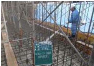
型枠面、打継面の散水
