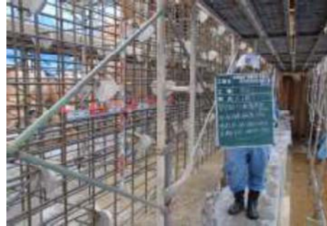
補強鉄筋B（表面付近への補強鉄筋）
