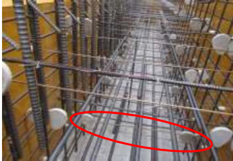
補強鉄筋A（リフト下端への補強鉄筋）
