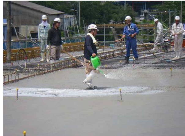
被膜養生材(マスターキュアー)散布状況
