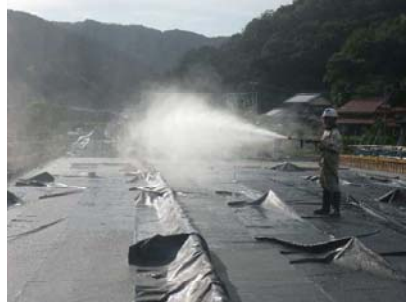
コンクリート打設直後散水状況
