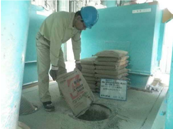
膨張材投入状況(プラント)
