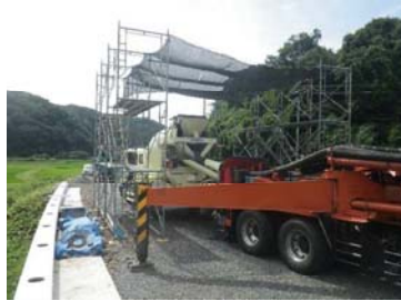
・ A2橋台側
