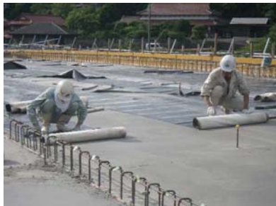
養生マット(アクアマット)設置状況
