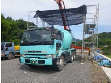
・ A1橋台側
