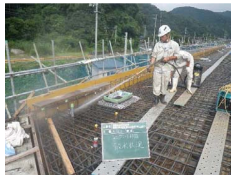
型枠面、打継面 の散水
