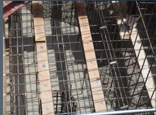
バイブレータの挿入間隔を50cm以下とするため、足場板に目印を付けている例
