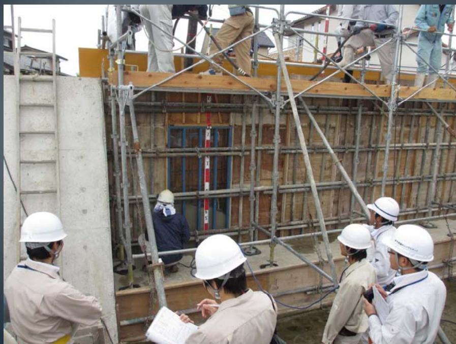
透明型枠を使用し、打込みの状況を確認し易くしている例
