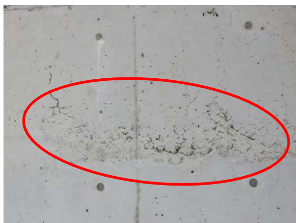
【ボックスカルバート側壁】
