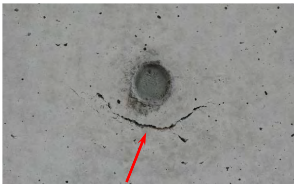
【セパレータコーン跡下方】
