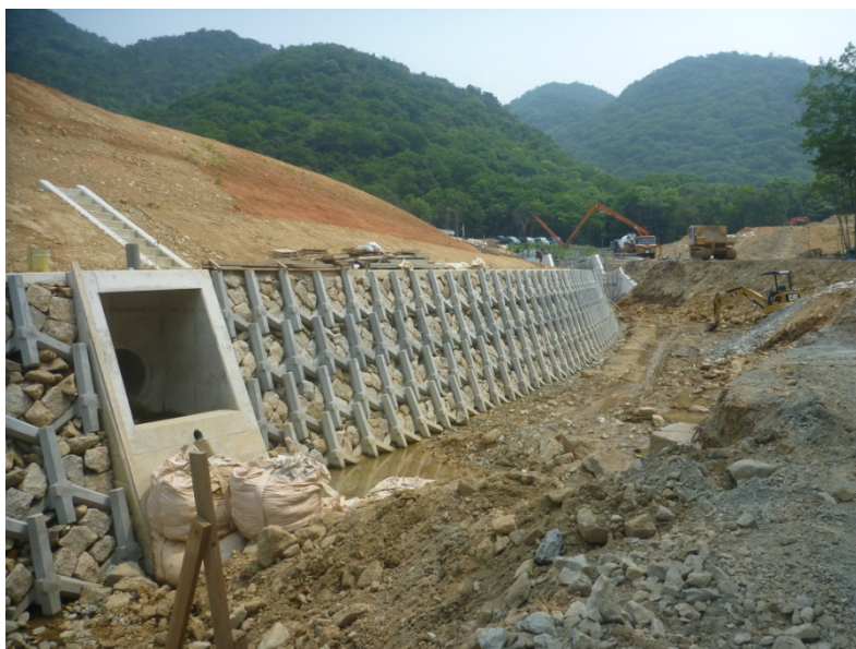
▲山口市系根新堤 農業用ため池改修工事 放流水路工
