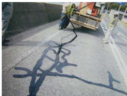
注入の状況 （ポリフレックス#1）
