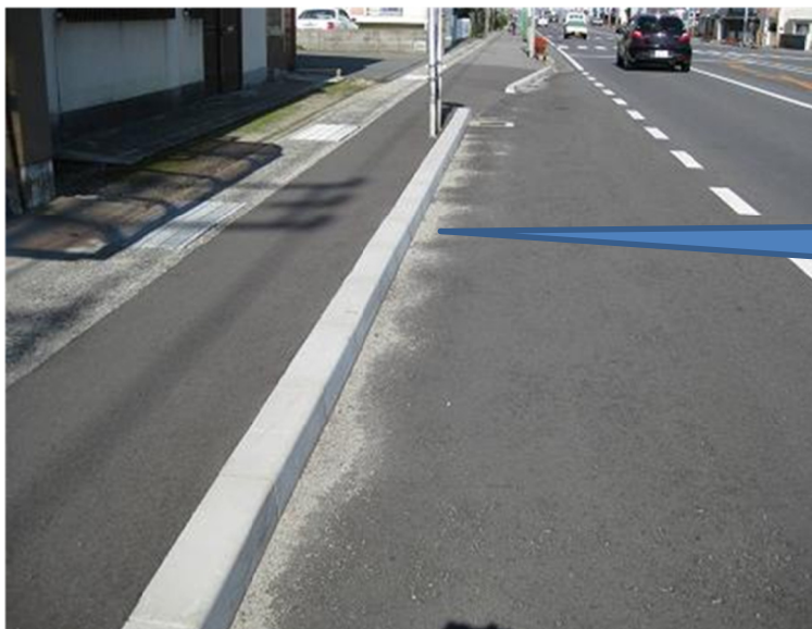
モデル事業での施工事例
