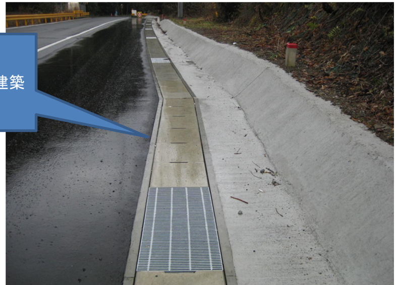
モデル事業での施工事例
