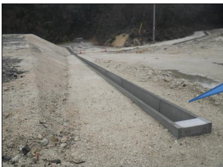
モデル事業での施工事例
