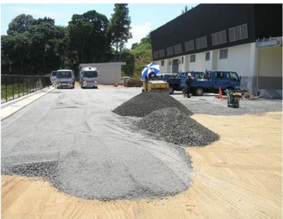
外構・駐車場の敷き 均し転圧作業(CS-30)
