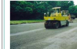
下層路盤材施工状況
