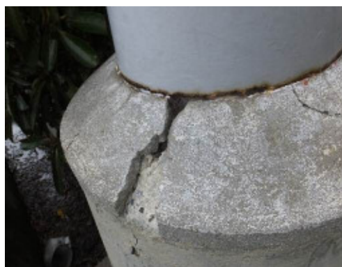
<下部構造の損傷状況>
