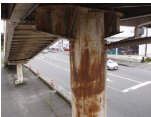
<下部構造の損傷状況>
