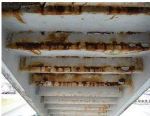
<階段部の損傷状況>
