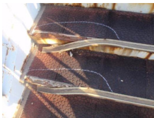
<階段部の損傷状況>
