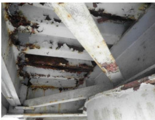
<上部構造の損傷状況>
